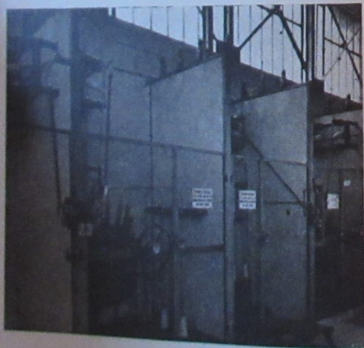
Fig. 22. — Verrouillage de sécurité dans une cabine de transformation.
