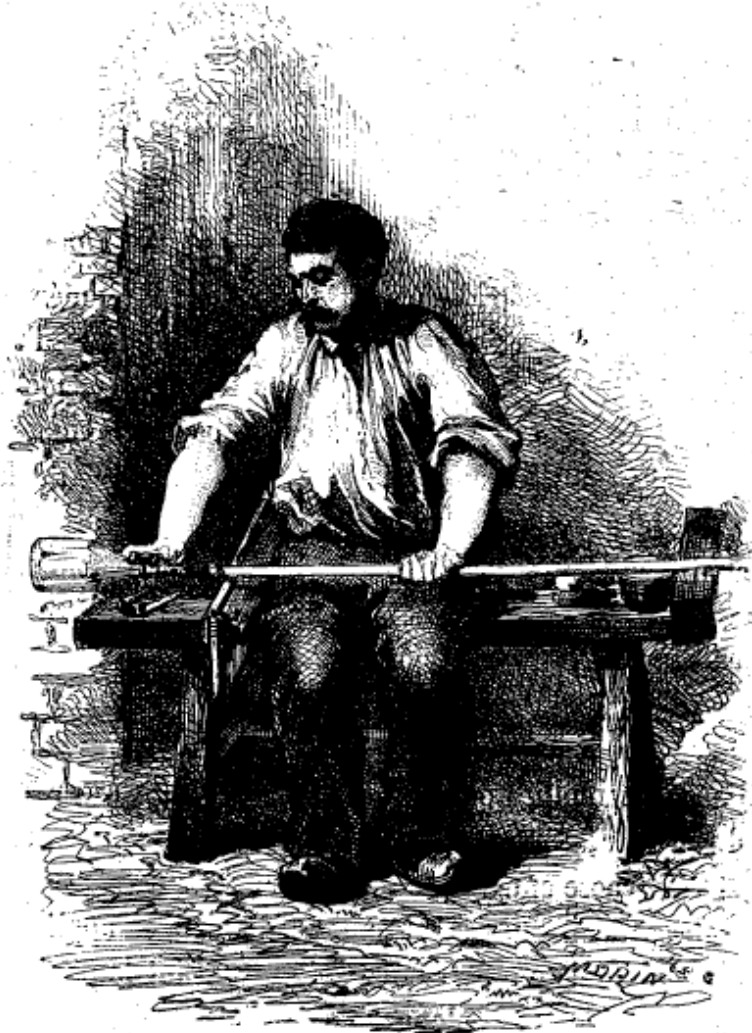
Verrier fabriquant une carafe (ciiché Dulos, d'après une photographie de Franck).
