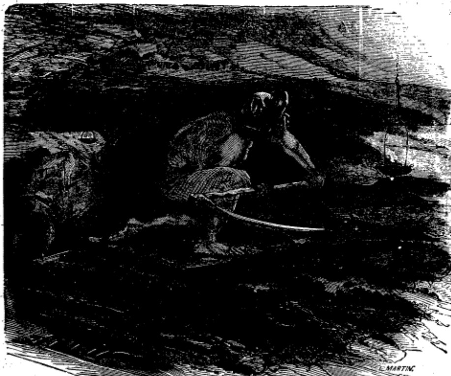
Mineur au chantier.
